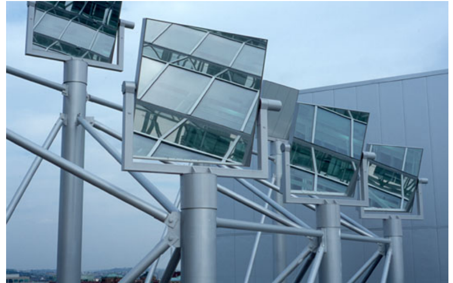
Refletores na cobertura
